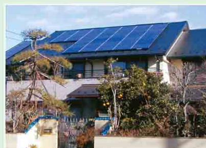
7.2kW M様邸発電所
