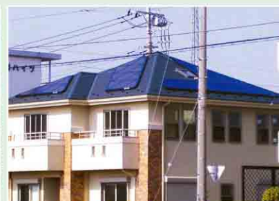
4.2kW F様邸発電所
