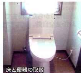
床と便器の取替
