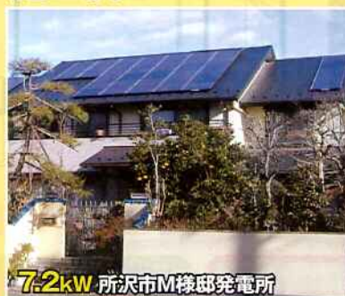
7.2kW 所沢市M様邸発電所
