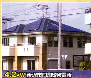
4.2kW 所沢市F様邸発電所
