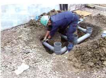
配管の接続完了
