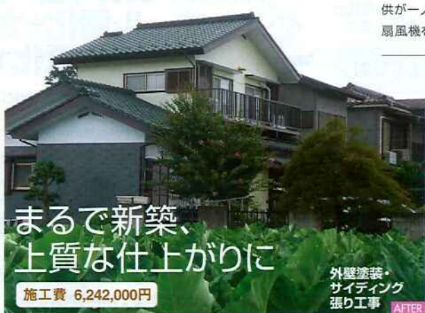
O様邸 (所沢市) 外壁リフォーム 水廻りリフォーム
