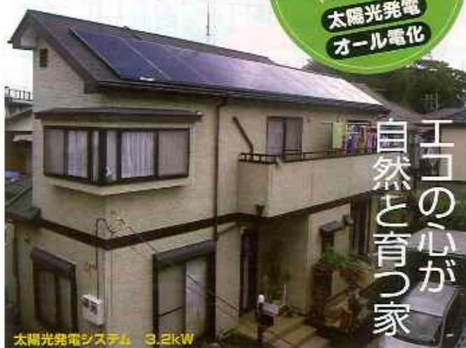
太陽光発電システム 3.2kW
