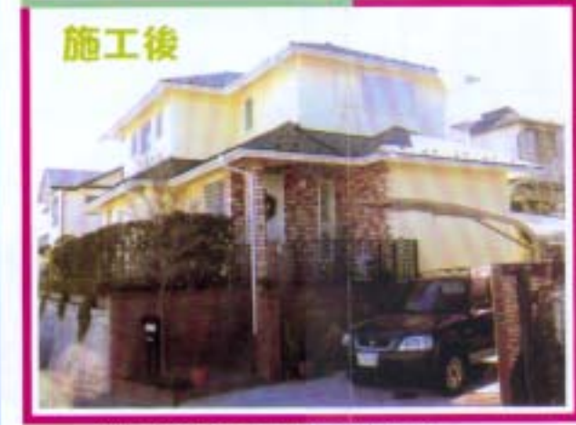
▲写真のタイル工事は別途となります。タイル張りをご希望の方はご相談下さい。
